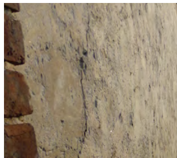
- Enduit en bauge sur bâti ancien Grande Rue -
