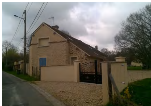
- Un corps de ferme réhabilité -
