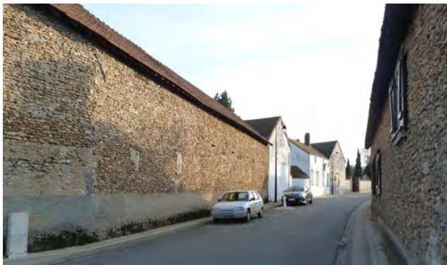
- Ancien corps de ferme dans le bourg Grande Rue -
